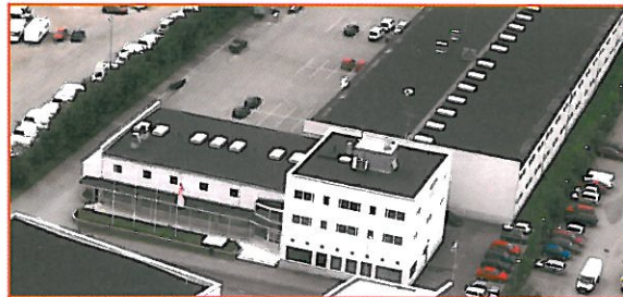
Scanoffice Oy:n toimisto- ja logistiikkakeskus Vantaalla käsittää yhteensä 2900 m² nykyaikaista toimitilaneliötä.
